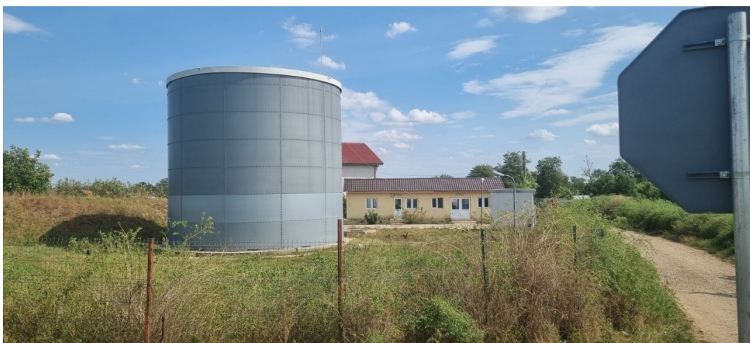
Alimentare cu apă în comuna Unirea – Stația de pompare
