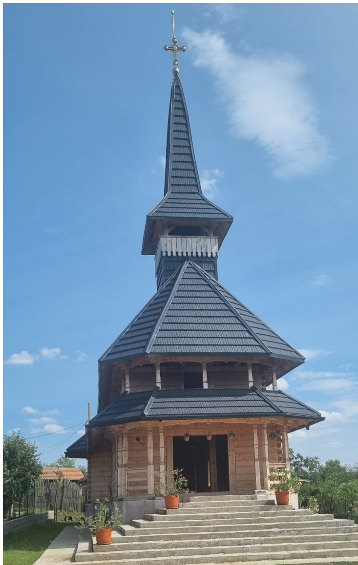
Biserica de lemn – Unirea (aflată în faza de construcție)
